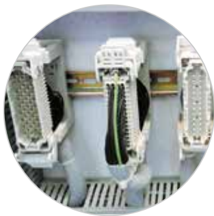
柜内安装采用导轨式案例
